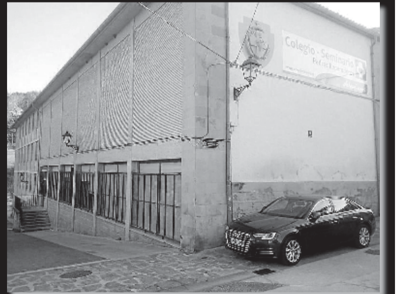
Acceso lateral al colegio Padres Reparadores de Puente.
